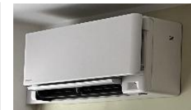
Ergänzung Erdgaskessel mit Klima-Splitgerät (Luft-Luft-Wärmepumpe)
